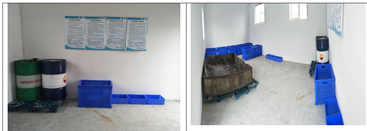
图 7 危废间现场照片
