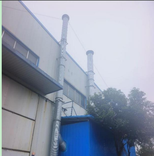
左：固化废气排气筒，右：除尘废气排气筒
